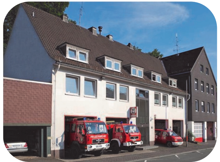
Feuerwehrgerätehaus in Finnentrop
